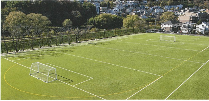
県立学校初の全面人工芝の第2グラウンドを整備
