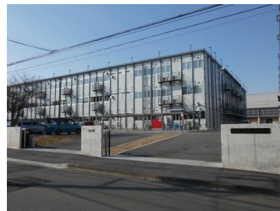
仮設校舎（令和2年8月から使用）
