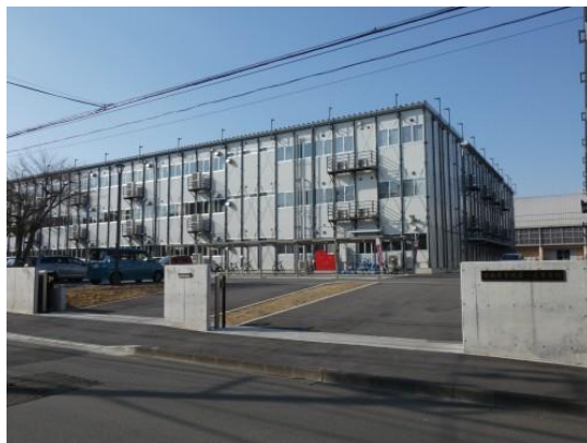
仮設校舎（令和2年8月から使用）
